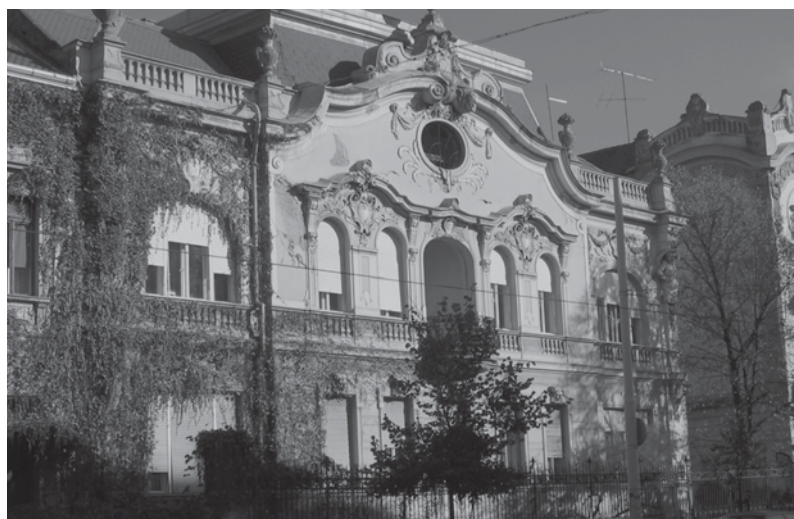
Kuća Kastenbaum, Osijek, Europska avenija 12.
